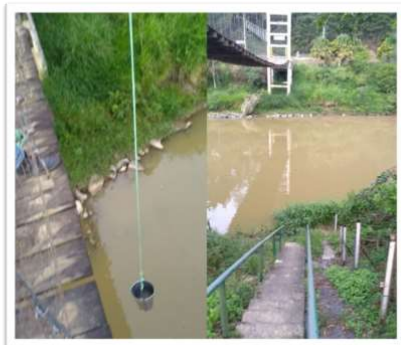
Figura 5 - SC-7754-I-7- Ituporanga - Ponte pênsil da SC 350 sobre o Rio Itajaí do Sul
